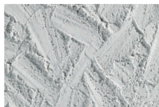
Нанесение с помощью шпателя
