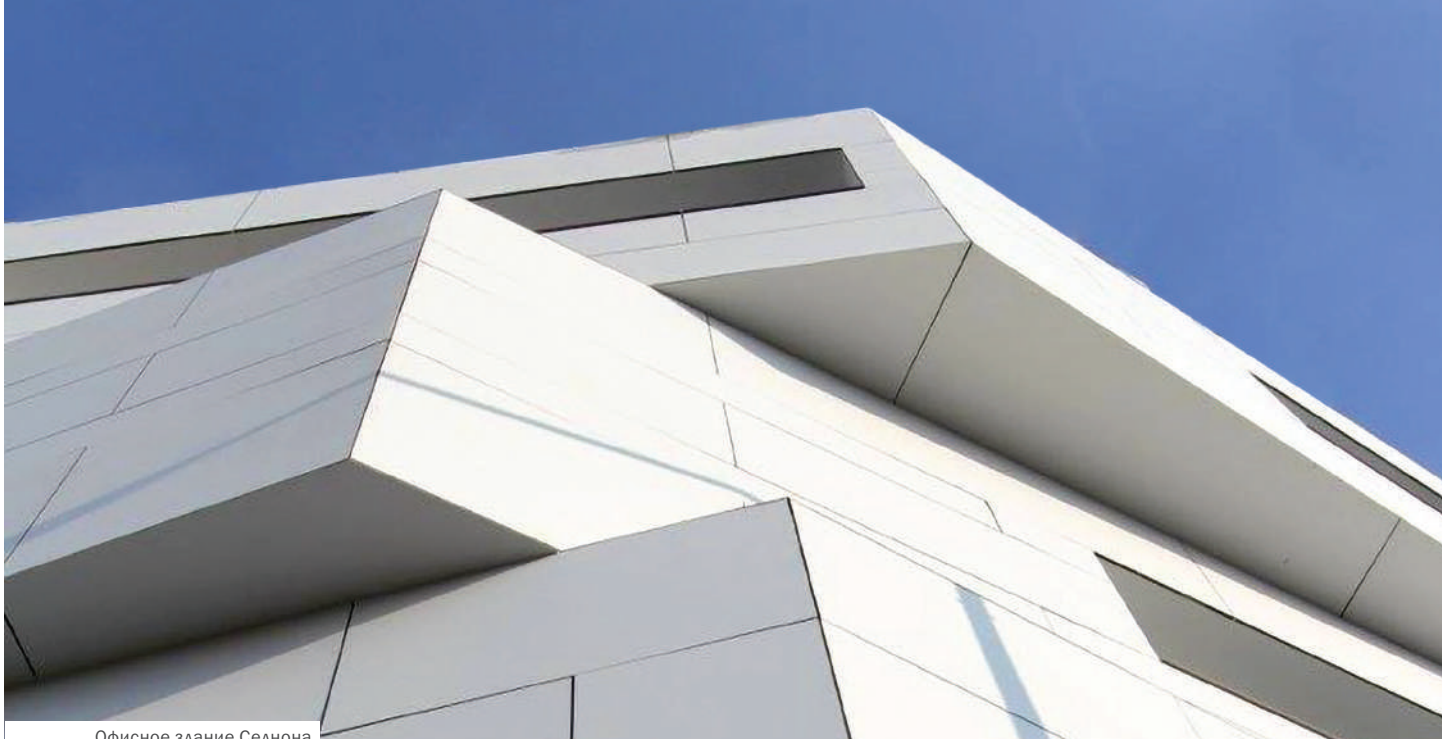
Офисное здание Седнона
