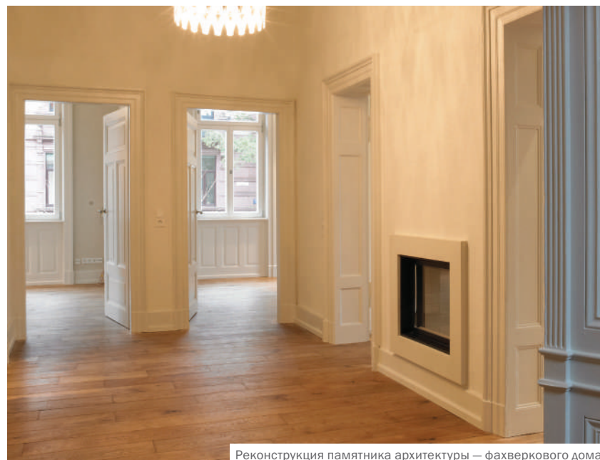
Реконструкция памятника архитектуры — фахверкового дома
