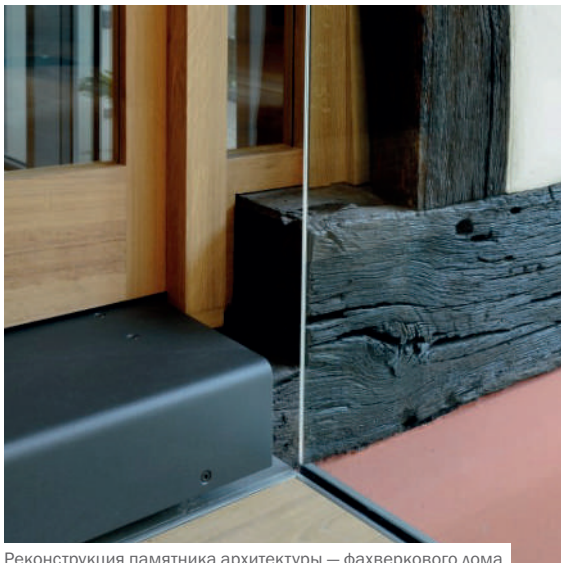
Реконструкция памятника архитектуры — фахверкового дома
